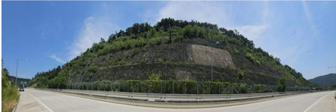
영천절토 34 (관리이정 1.890~2.150km / 5공구 군위R-A(중앙)STA.1+890~2+150)
